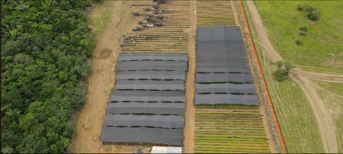
Infrastruktur: Errichten der Baumschule
